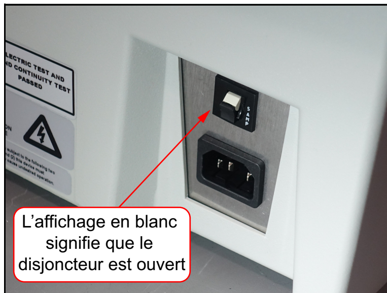
Figure 4-21 : Ouverture du disjoncteur
